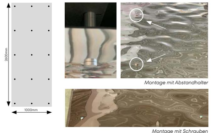
Vorbohren: Bohrdurchmesser = Schraubendurchmesser + 1mm
