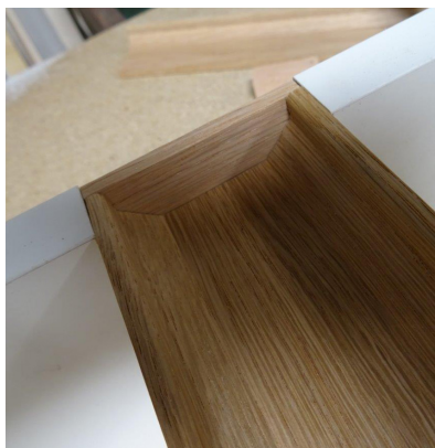
Vedere interioară: Mâner-baghetă cu capac de capăt
