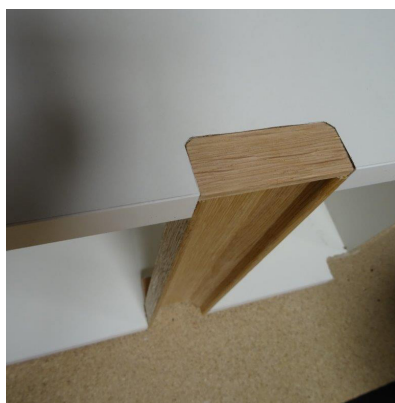
Przyklejenie zaślepek końcowych - widok z zewnątrz
