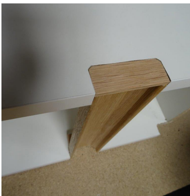
Eindkappen vastlijmen - hier gezien vanaf de buitenkant
