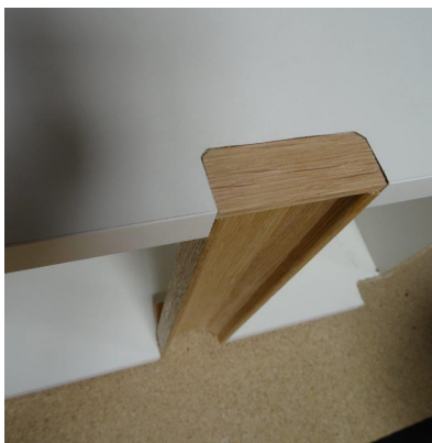
Collage des embouts : vue extérieure
